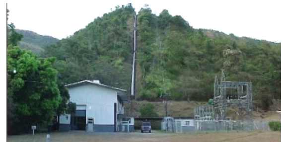
Hidroeléctrica La Yeguada en Calobre, Veraguas
